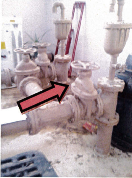
Sewer Effluent Discharge Valve
